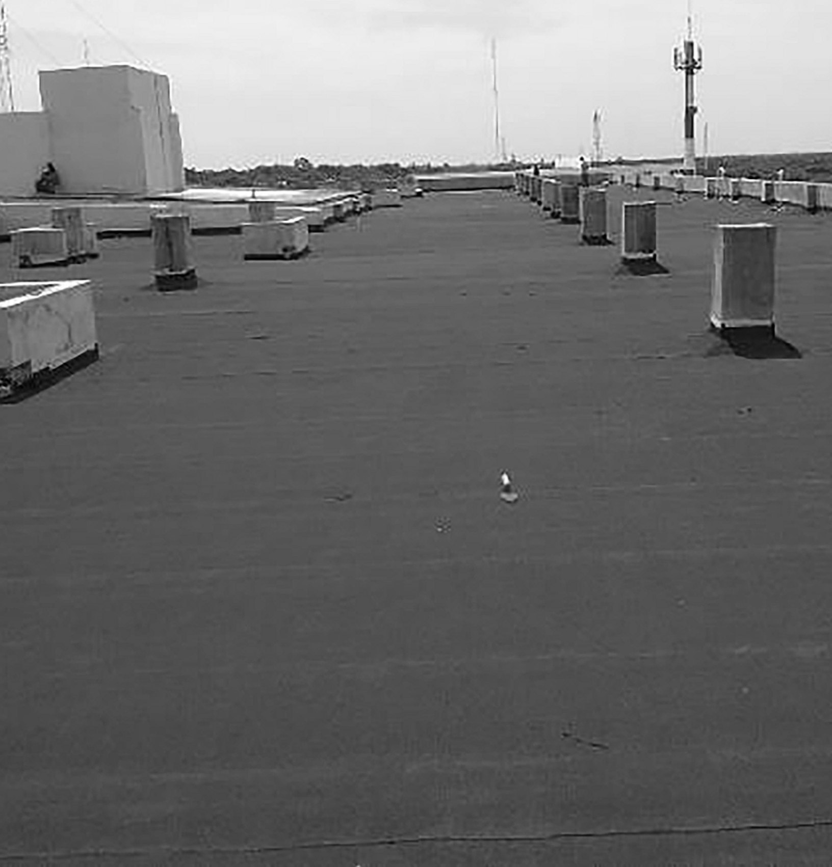
Plaza comercial playa del carmen 7000 m 2 sistema prefabricado technoply SBS SP 4.5 mm.
