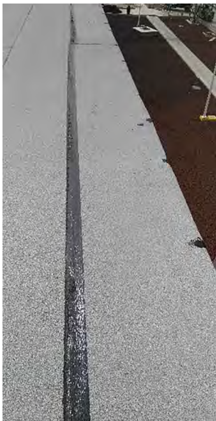
C.F.E. Texcoco Edo. Mexico 3,700 m 2 sistema prefabricado technoply SBS SP 4.5 mm. y espuma de poliuretano asreado.
